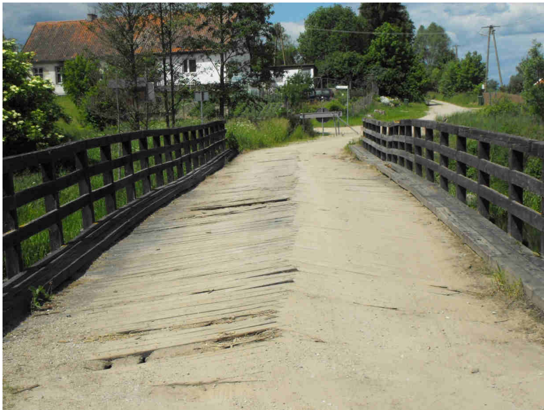
Fot. Mostu przed modernizacją
