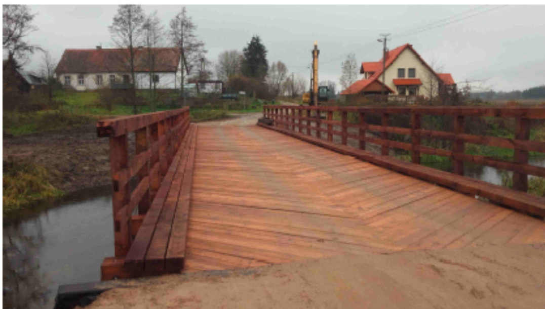
Fot. Mostu po remoncie
