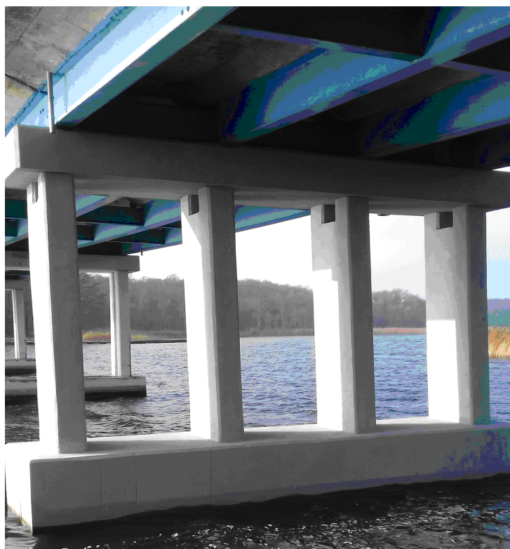
Fot. 6 Filar nr 7 „Mostu Sztynorcki” po wykonaniu remontu
