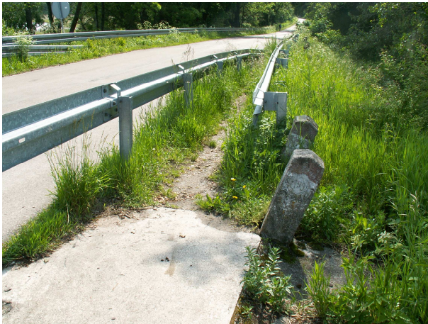
Rys. 17. Uszkodzone i beładnie wychylone słupki barier na przyczółku początkowym
