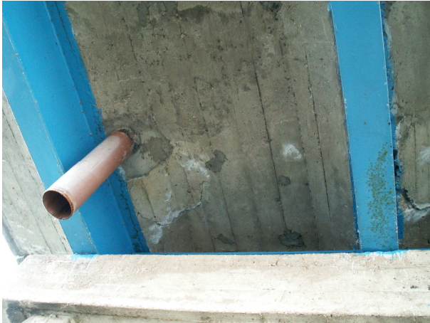
Rys. 9. Nacieki korozji ługującej betonu i korozja dolnej półki belki nośnej przy F1
