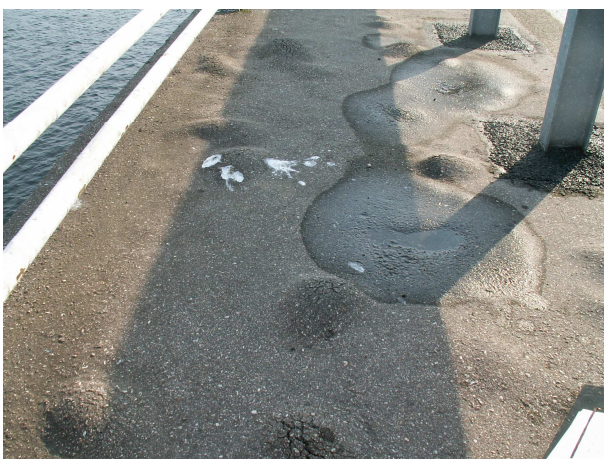
Rys. 11. Spękania nawierzchni jezdni w obrębie przęsła F7-Pk
