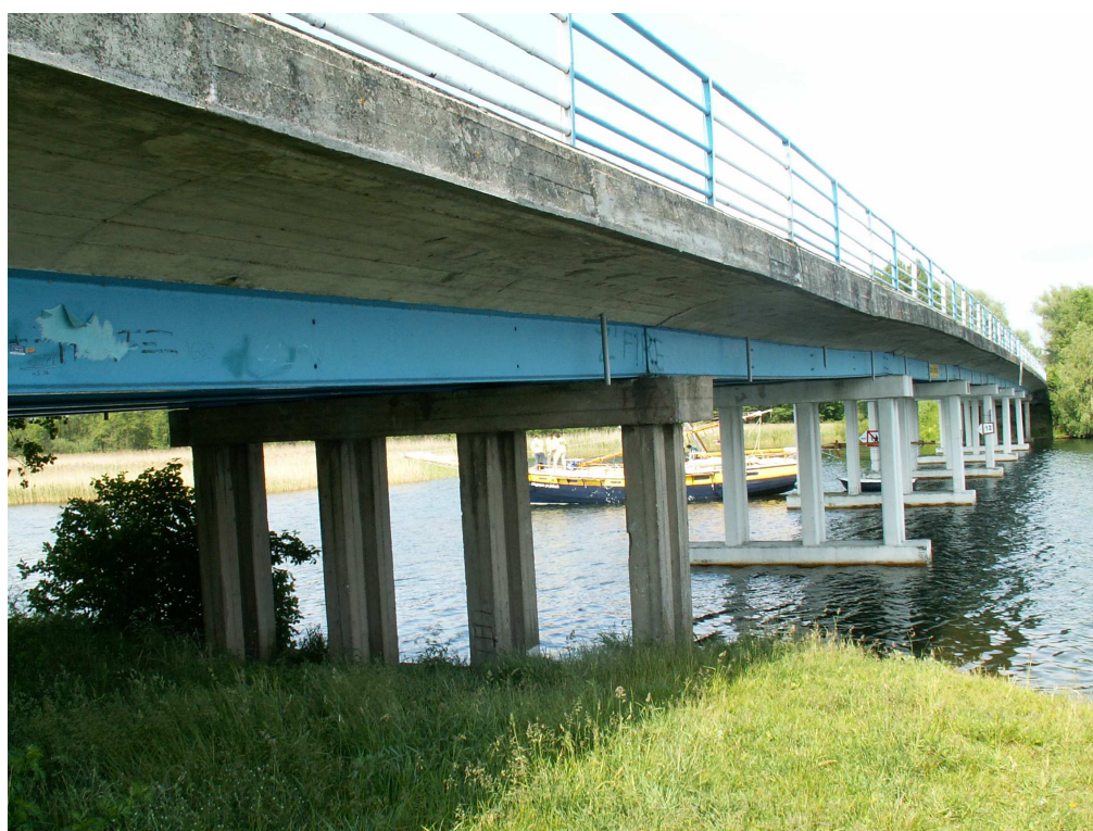
Rys. 1. Widok ogólny mostu od strony Pozedrza (lewy koniec mostu)
