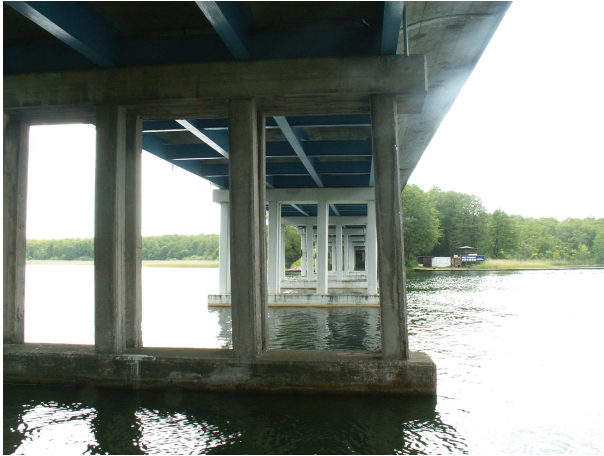
Rys. 3. Odchylenia od pionu w różnych kierunkach słupów filara F7
