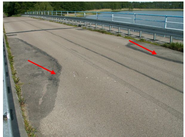
Rys. 12. Spękania nawierzchni jezdni w obrębie przęsła F3-F4
