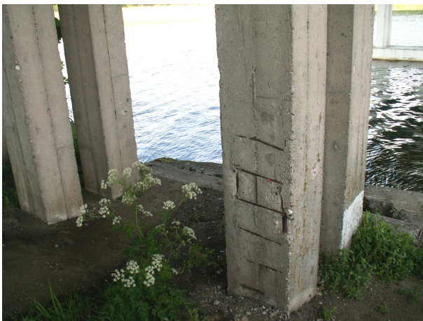
Rys. 3. Odchylenia od pionu w różnych kierunkach słupów filara F7
