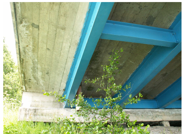
Rys. 6. Zaawansowana korozja betonu i zbrojenia oczepu dolnego filara F7
